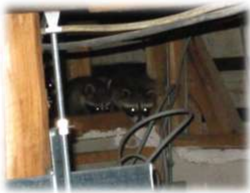
(天井裏の様子)
